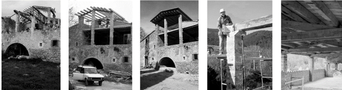
Façana original, en fase d'obres, obra acabada, detall carreus de travertí i detall encavallada.
