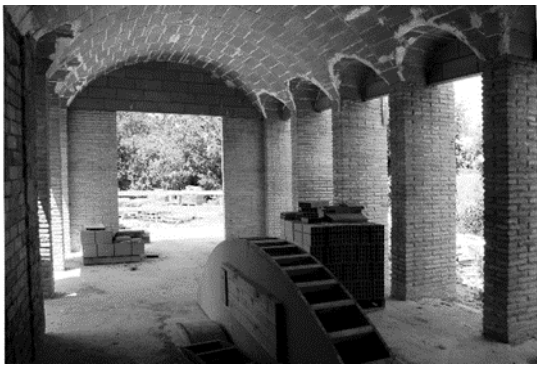
Volta catalana en fase de construcció i volta un cop acabada l'obra. Font www.bangolo.com
