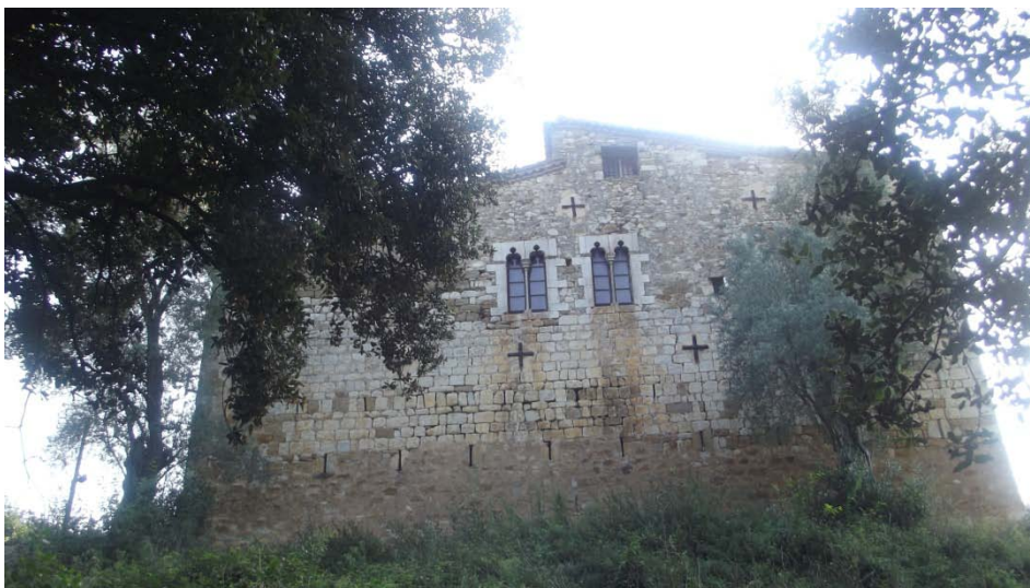
Fig.4: Vista del parament occidental de l'edifici.
