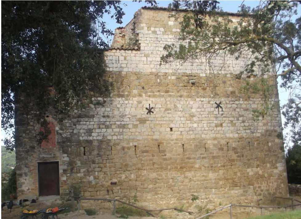
Fig.3: Vista del parament oriental de la torre.
