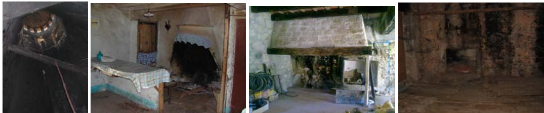
Figura 10: campana de foc central o rodó.
